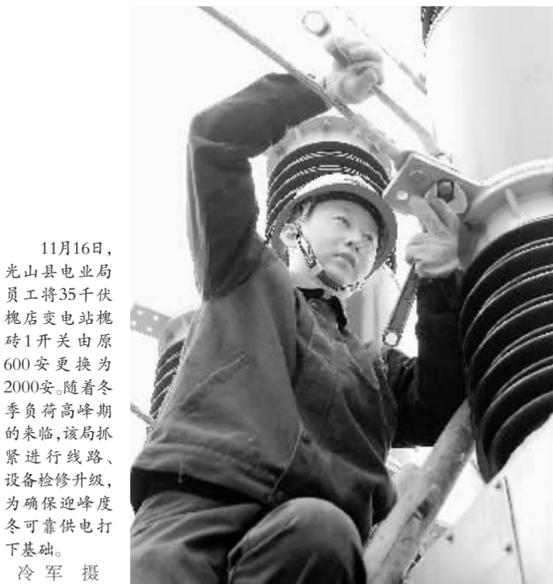
11月16日,光山县电业局员工将35千伏槐店变电站抱砖1开关由原600安更换为2000安。随着冬季负荷高峰期的来临,该局抓紧进行线路、设备检修升级,为确保迎峰度冬可靠供电打下基础。 冷军 摄
