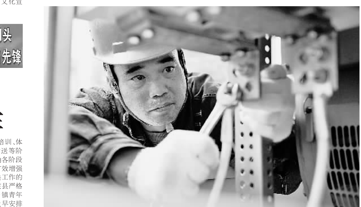
近日,固始县电业局针对秋检中发现的设备缺陷进行全面整改,及时消除安全运行隐患,为即将到来的冬季用电高峰做好准备。图为该局员工正在认真检修设备。 高伟 摄
