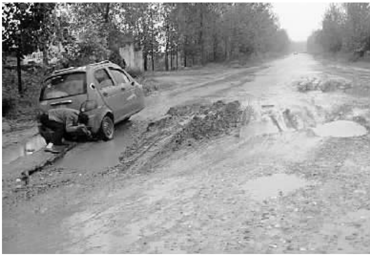
图为被损毁的路面。
