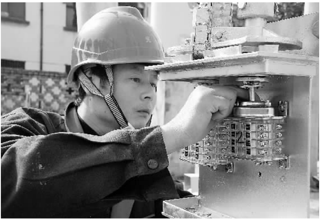
自10月份份开始,光山县电业局全面开展线路、设备综合治理工作,消除安全隐患,改善设备状况,提升供电能力,为确保冬季负荷高峰期间电力可靠供电打好基础。图为10月30日,该局员工正在更换35千伏仙居变电站35千伏母线和线夹的场景。 冷军 摄
