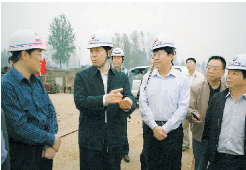
图为郭瑞民在淮特大桥施工现场视察时的情景。本报记者 方慧玲 摄
