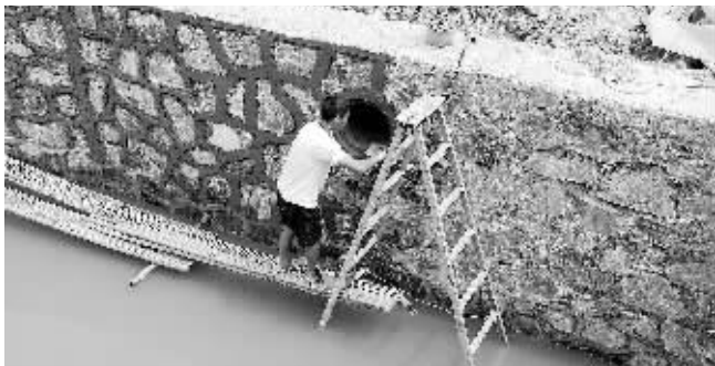
为提高城市防洪排涝能力,优化内河周边环境,市委、市政府连续3年将中心城区内河治理作为向市民承诺的“十件实事”之一。3年来,共完成了中心城区7条内河的治理任务,同时拆除阻水建筑物15处,实施桥涵改造44座,总投资近2亿元。上图为片石护坡下清清的河水。左图为施工人员在砌内河护坡。
