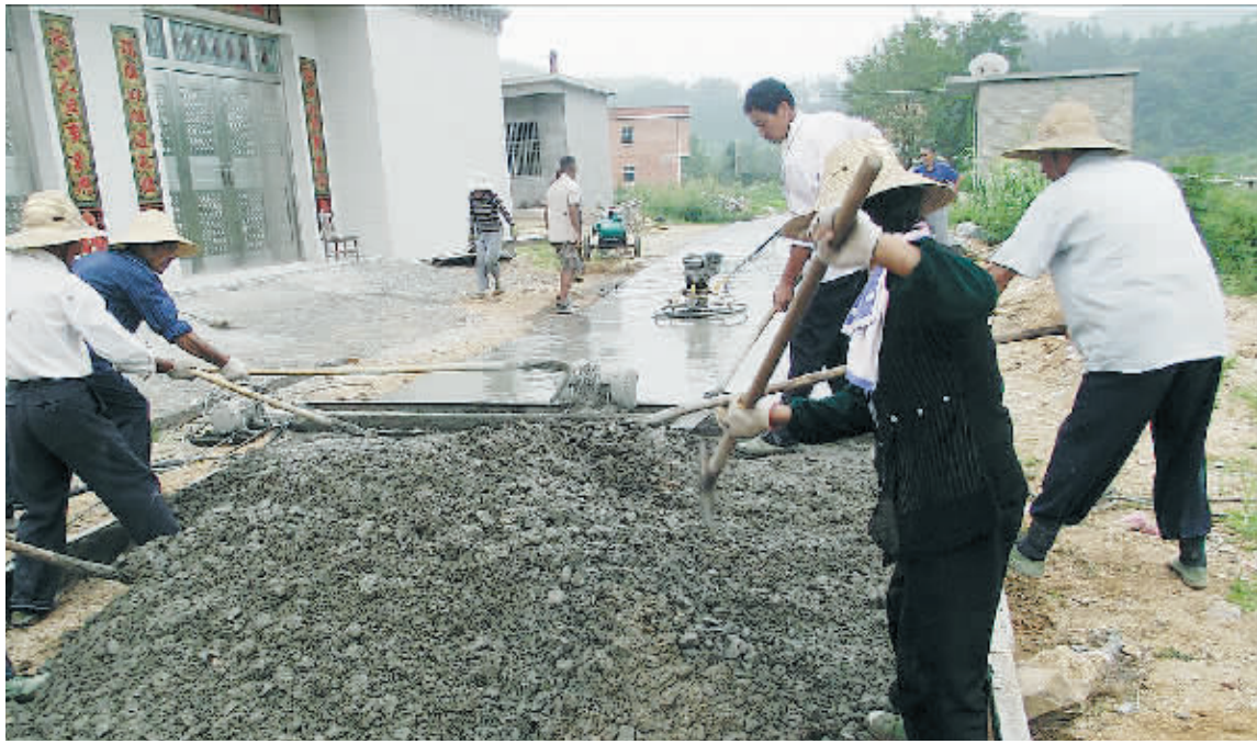
商城县余集镇迎水村是国家级贫困村,地处浅山区,用车辆运送货物只能绕道邻近的新县境内出村,往返非常不便。市人力资源和社会保障局选派干部,迎水村党组织第一书记李广清看在眼里,急在心里,经多方协调,努力争取到专项资金50万元用于扩修道路。眼下,一条长2.8公里、宽3.5米的公路平整拓宽工程已经完工,硬化工程正在紧张施工之中,预计8月下旬竣工。图为施工现场。 本报记者 黄颖 摄
