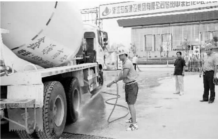
按照创优国家标准,施工工地出入口是5米以上的硬性路面,运输车辆驶出施工场地前必须对车轮进行冲洗,保证不带泥土上路。图为百花园区域百花酒店B座建设工地对将要出场的混凝土搅拌车的车轮进行冲洗。 本报记者 方慧玲 摄
