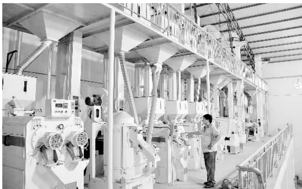
日前,河南金丰农业开发有限公司低温升碾米生产线在息县产业集聚区完成安装调试。据悉,该生产线是信阳市唯一一条将稻谷碾磨后进行仓内冷却灌装的精米生产线,可年生产精米10万吨。图为该公司技术人员正在对设备进行最后检测。
