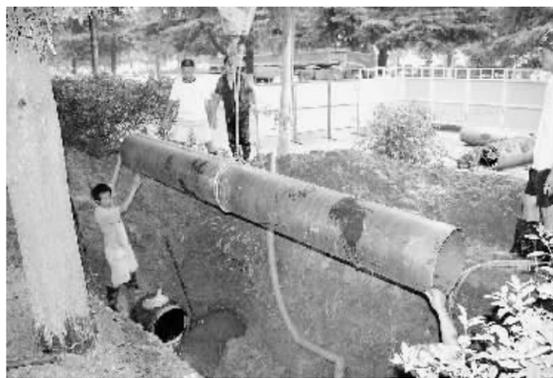
由于我市自来水管网严重老化,7月18日上午,鸡公山大街358厂附近自来水管爆裂,造成鸡公山大街部分居民、商户停电。事故发生后,市供水公司立即组织人员进行抢修,用高质量的钢管替代破裂混凝土供水管道,保证附近居民和商户今后能稳定用水。 记者 曹新俊 摄
