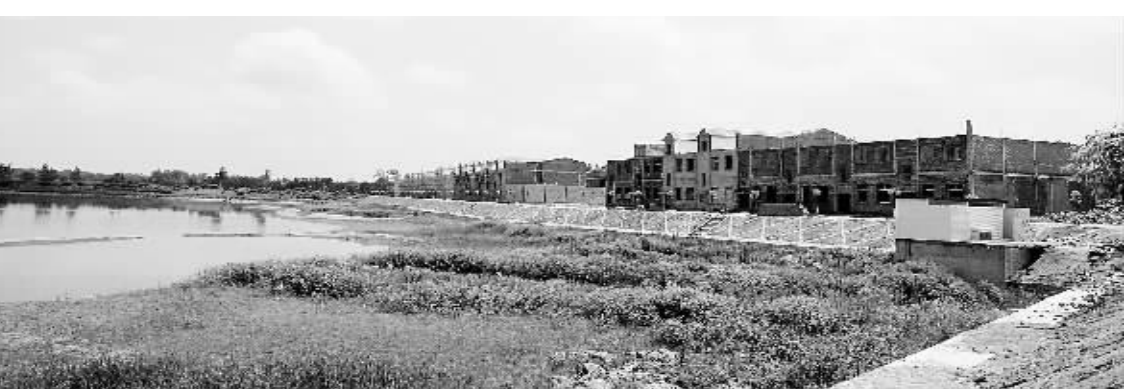
图为正在建设中的光山县仙居乡长兴镇村农民新村。
