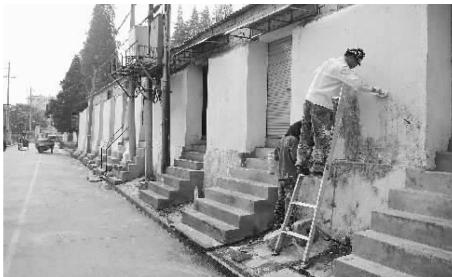
在创卫整改攻坚中,平桥区平西办事处对团结路、物价胡同等背街小巷脏乱的墙面重新刷白,适宜的地方还刷上了创卫宣传标语,使之焕然一新。图为工人正在粉刷旧墙面。 本报记者 方慧玲 摄
