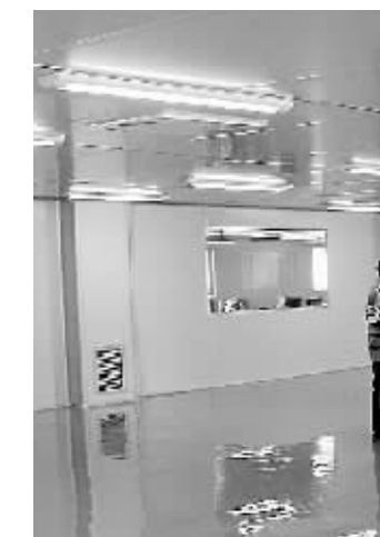
日前,天盈集团天阳光电科技有限公司的首批设备已抵达信阳工业城电子产业孵化园。6月28日上午,各项设备已全部卸完,计划7月上旬完成安装调试,月中进入试生产阶段,届时,我市第一条科技含量高、生产工艺先进的液晶面板生产线将投产。图为天阳光电科技有限公司无尘生产车间。何恒渊 摄
