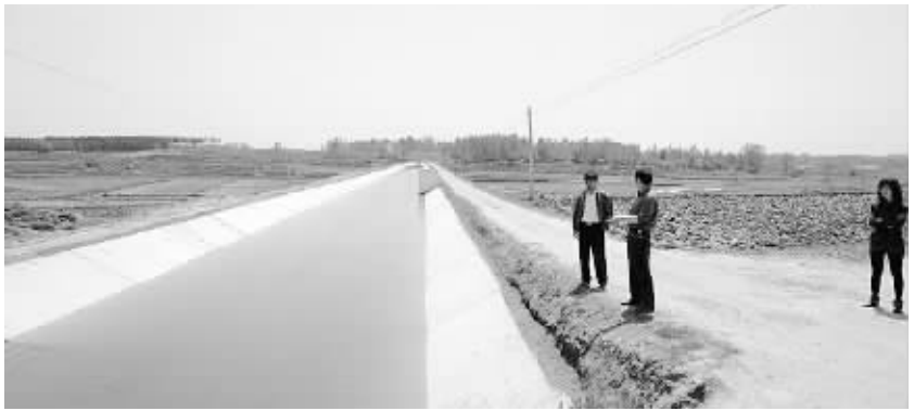
图为鲇鱼山水库灌渠。该水库今年以来为抗旱灌溉累计供水2.54亿立方米,灌溉面积达140万亩。雪峰摄
