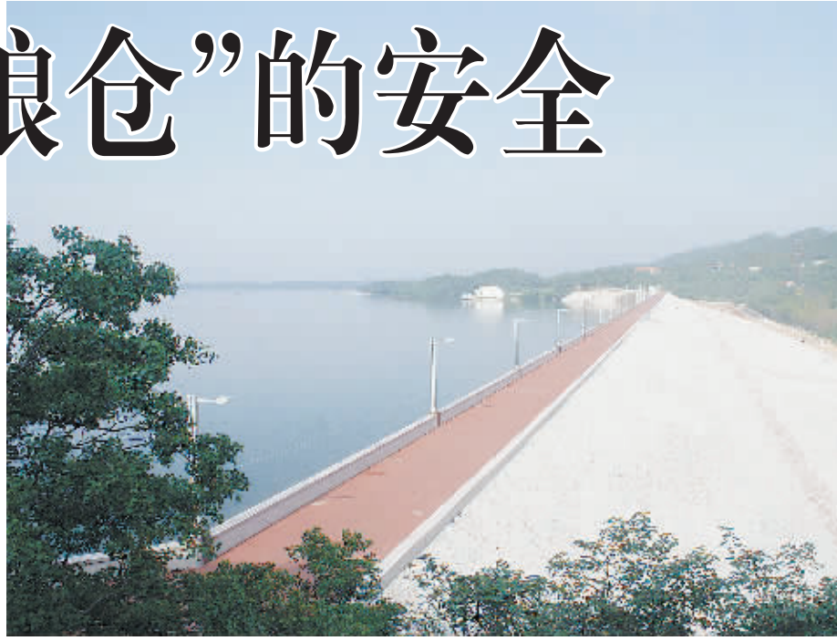
图为南湾水库除险加固后的主坝新貌。 雪峰 摄
