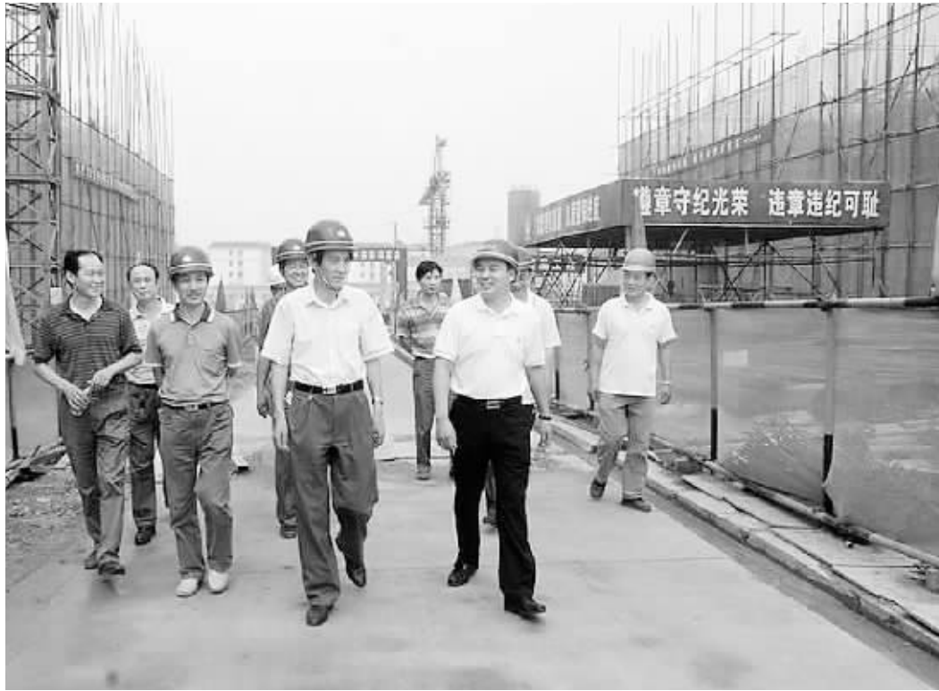
图为市住房和城乡建设局局长程震南(中)深入施工现场检查指导安全生产暨建筑工地“创卫”达标工作。
