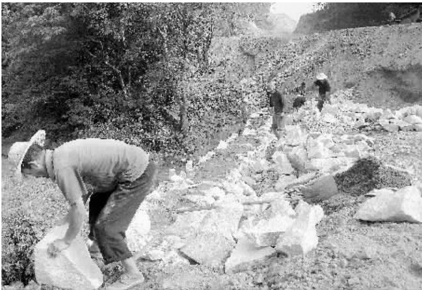
在试验区建设中,浉河区把落实村民一事一议筹资筹劳财政奖补工作作为加大农村资金投入的重要工作来抓。去年,全区落实奖补项目149个,修建道路236公里,修复水渠9公里,建设蓄水池工程11处,共投入资金2415万元。图为近日浉河区五星办事处琵琶山村修建村组道路时的情景。易斌 摄
