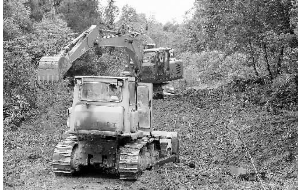
近日,浉河区五星办事处马鞍村通过村集体筹资、财政扶持的办法,筹集资金400余万元计划修建一条长3.5公里,路基宽8米,水泥路面宽6米的高标准村级水泥路。因为工程机械正在挖掘平整路基。 刘文强 摄
