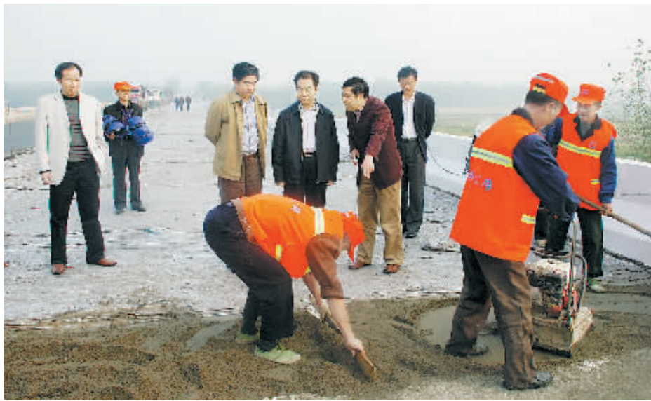
市政府副市长张明春(左四)和市公路局负责同志在107线甘岸淮河大桥施工现场。 王敏摄
