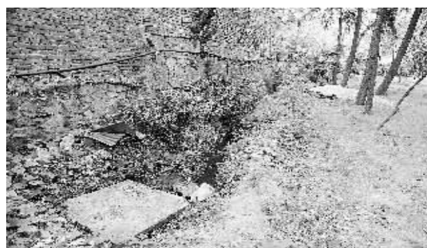
图为发出恶臭的化粪池。
