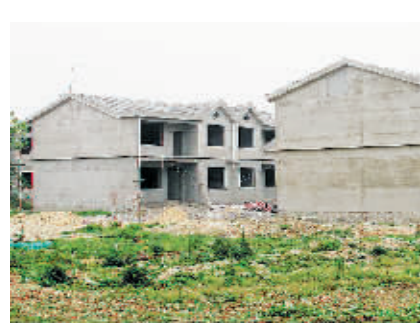
正在建设中的先锋新村农民安置小区
