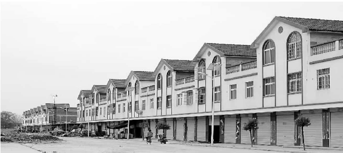
图为吴家店镇正在建设中的锦春园社区
