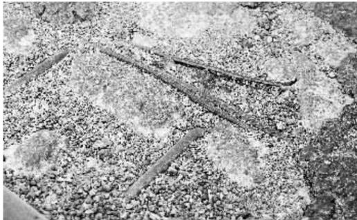
图为虹桥桥面上裸露的钢筋。
