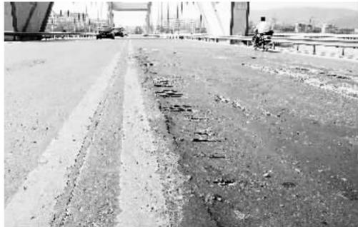
图为桥面中间露出的钢筋头。
