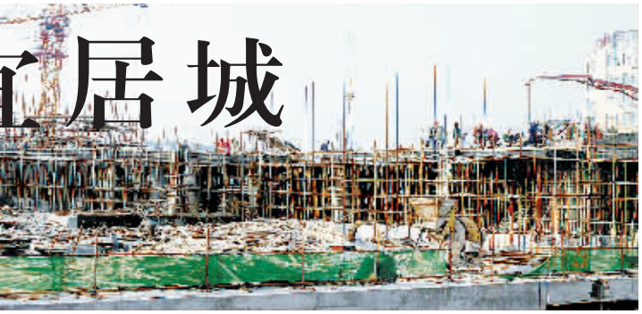
图为正在建设中的崇福家苑。
