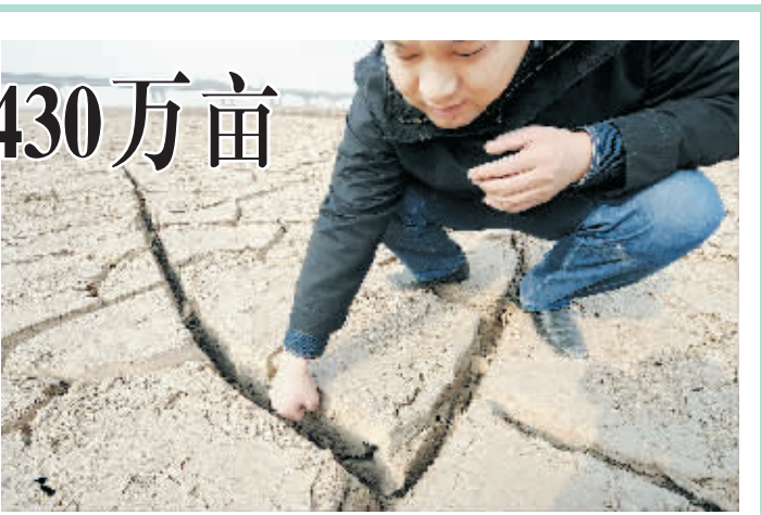
这是郑州花园口黄河段面裸露的河床上布满龟裂的缝隙(2月23日摄)。 新华社记者 朱祥 摄
