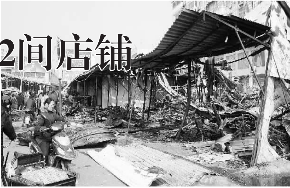
图为被火魔吞噬过的火灾现场。
