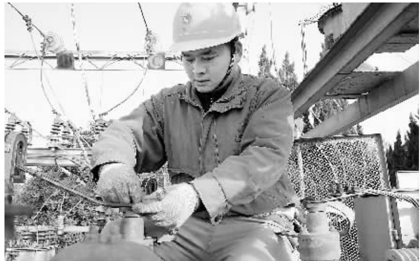
1月15日上午,因用电负荷过大,35千伏寨河变电站设备发热严重,光山县电业局紧急进行处理,确保了设备的可靠供电,图为抢修时的情景。冷军 摄
