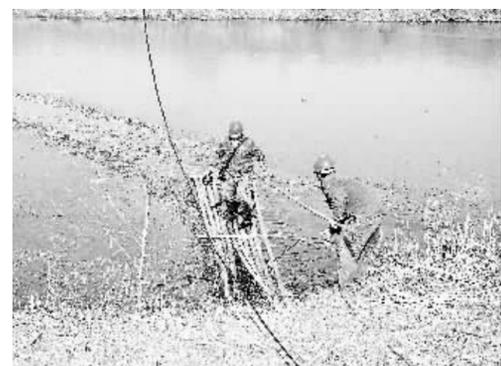
1月9日,羊山新区汪3线信阳职业技术学院分支因某公司吊车施工挂断该段高压分支,信阳供电公司克服地形复杂等不利因素,破冰抢修。
