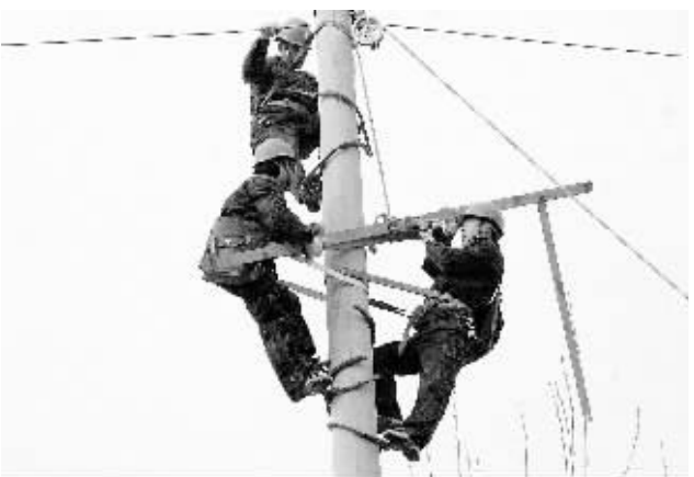
2010年12月29日,罗山某施工队作业时,挖掘机不慎将江淮北路10千伏罗4线35号电杆撞断,罗山县电业局组织人员快速抢修,仅用3个多小时就恢复供电。图为抢修时的场景。魏思平 摄
