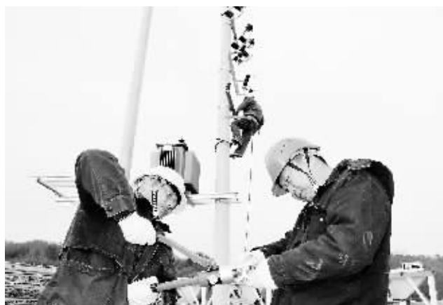
2010年12月29日,信阳供电公司工作人员为鸡公山志高动漫园建设和站架架供电线路。林平 摄
