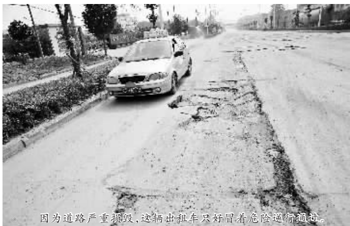
因为道路严重损毁,这辆出租车只好冒着危险强行通过。
