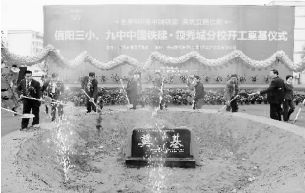
11月13日,市三小、市九中分校开工建设。该校由中铁建设集团(信阳)房地产开发公司出资3000余万元修建,占地30亩,可容纳2300名学生,预计将于明年9月投入使用。市领导高俊峰、尹保武、廖长明和市长助理师勇出席开工典礼。图为开工仪式现场。
