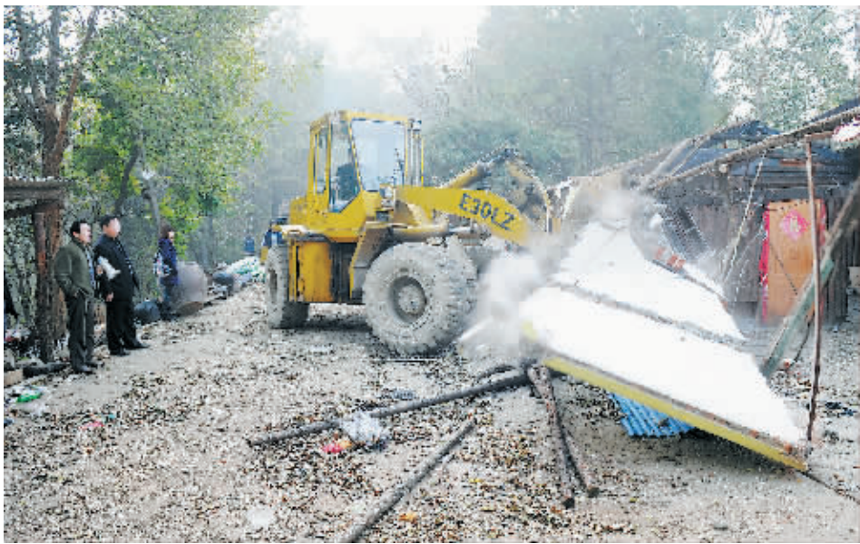
为认真贯彻《河南省信阳市南湾水库饮用水水源保护区条例》,落实市委、市政府保护饮用水水源专题会议精神和,坚决遏制南湾湖风景区辖区内“地锅饭”对水源的污染行为,11月3日至4日,南湾管委会组织公安、工商、水利、环保、渔政、交通、卫生、城市执法等部门,对阮尼岛和二十里桥等区域11000余平方米范围内的违法搭建的砖混房、棚房、棚架等违法建筑进行了依法强制拆除。图为强制拆除机械组在作业时的场景。本报记者 张泽元 摄
