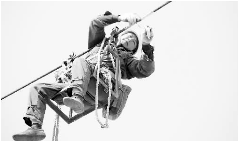
10月16日,淮滨县电业局对110千伏蓼荷输电线路进行越冬检修,确保输电线路始终处于良好运行状态。 牛青坡 摄
