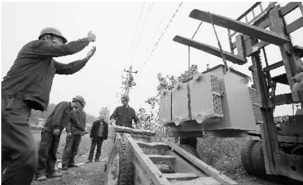
由于原有变压器已不能满足浉河区金牛山办事处和孝营村村民的用电需求,10月13日,信阳供电公司和对孝营村三组461号公变台区进行增容改造。 杨帆 摄
