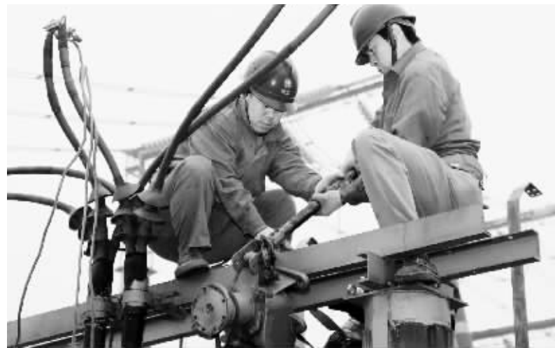
10月20日,信阳供电公司工作人员对220千伏沙港变电站电容器组刀闸进行完善化大修,确保迎峰度冬期间电网安全稳定运行。 王强 摄
