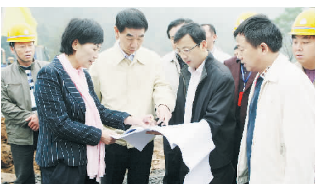
10月14日上午,市委书记王铁,市委常委、宣传部部长、副市长张春香,市政府副市长李水对鸡公山·志高文化科技动漫产业园项目工程建设进行现场办公。王铁对安置区建设、工程施工等提出要求,对有关问题现场进行了解决。当日上午,王铁一行还检查了琵琶台等浙河新八景建设。图为王铁等察看产业园内道路施工图、了解道路规划建设时的情景。 本报记者 吴非 摄
