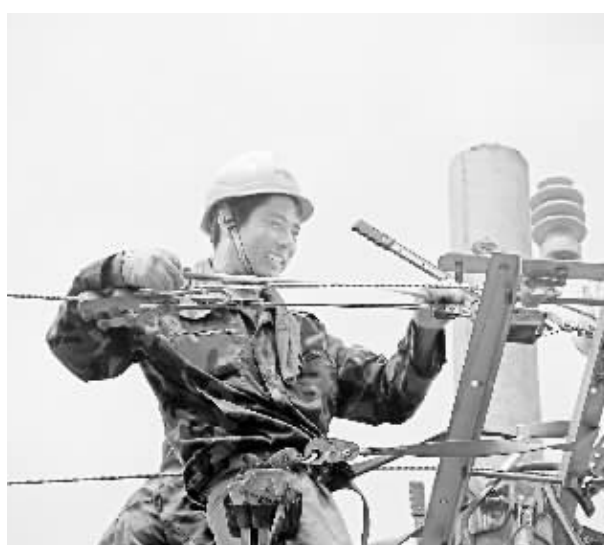
9月28日,淮滨县电业局安装公司人员对10千伏荷线新进行改造,以满足当地居民用电需求。 陈建侠 摄
