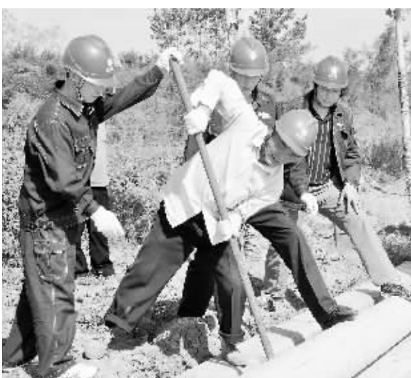
10月3日,信阳供电公司员工放弃节日休息时间,为平桥区工业园安装3台100千伏安路灯箱式变压器,组立电杆18基。图为员工组立电杆时的情景。 李斌 摄
