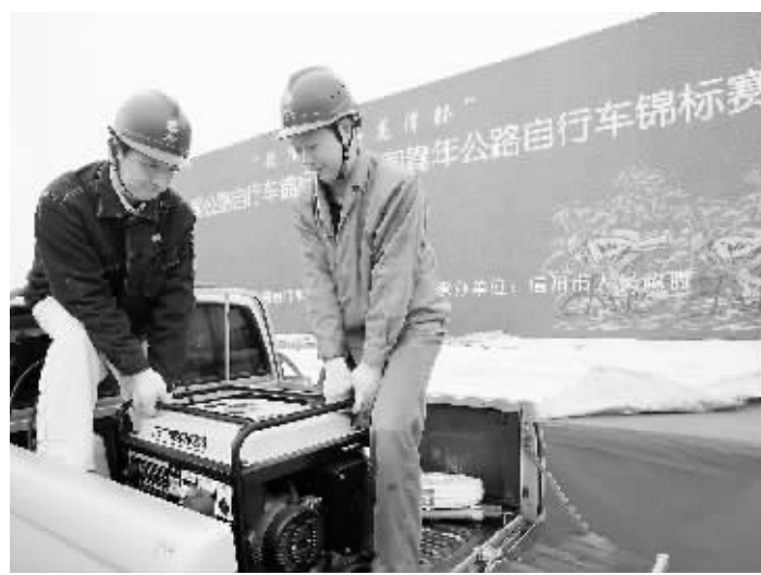
为全力做好全国公路自行车锦标赛开幕式及比赛期间的保电工作,信阳供电公司在重要场所安装临时电源和应急供电设备,确保可靠供电。图为25日该公司工作人员为开幕式现场安装应急发电机。 王强 刘威 摄
