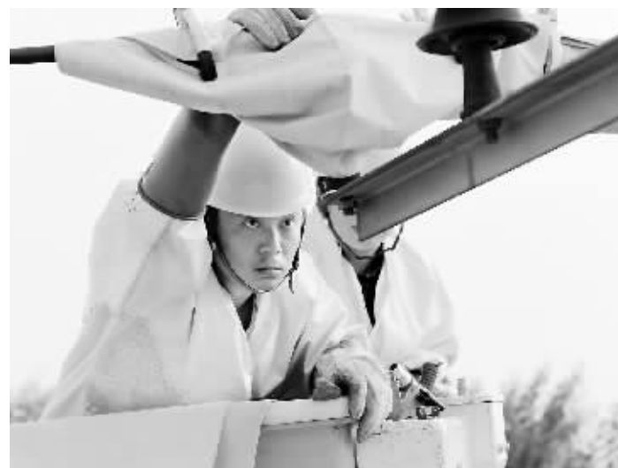
近日,信阳供电公司城区配网主供线路安装了近300个防雷线夹,增强线路防雷能力,确保可靠供电。图为9月20日,该公司工作人员为10千伏汪三线安装防雷线夹时的情景。 王强 摄
