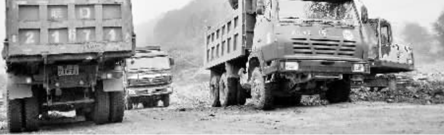
近期,鸡公山·志高文化科技动漫产业园加快建设步伐,紧紧围绕目标任务,抢时间,抓进度,各项工作有序推进。图为产业园正在加紧施工。 本报记者 张超 摄
