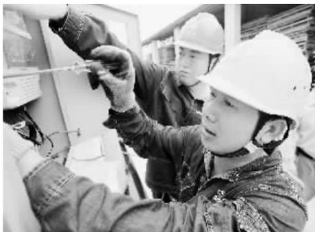
近日,信阳供电公司组织全市各乡鎮用户安装电能信息采集终端,实现乡鎮用电信息采集覆盖。图为9月15日,浉河区东双河镇供电所工作人员正在为一冷库用户安装采集终端。王强 摄
