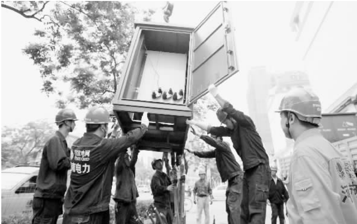
近日,信阳供电公司对经受夏季高温大负荷考验的供电设备进行全面排查检修,确保安全可靠用电。图为9月3日,该公司工作人员正在更换市区北京路05号电缆分接箱。王强 陈书义 摄
