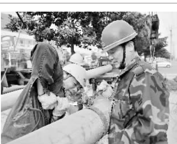
9月1日下午,固始县电业局员工经过3个小时的紧急抢修,排除了一起因汽车撞断线杆引发的险情,恢复了该线路的正常供电。高伟 摄
