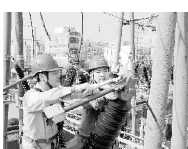
8月29日,110千伏罗山变电站数字化改造如火如荼地进行着。建成后,它将成为信阳电网第一座数字化变电站。甘仁伟 陈则勇 摄
