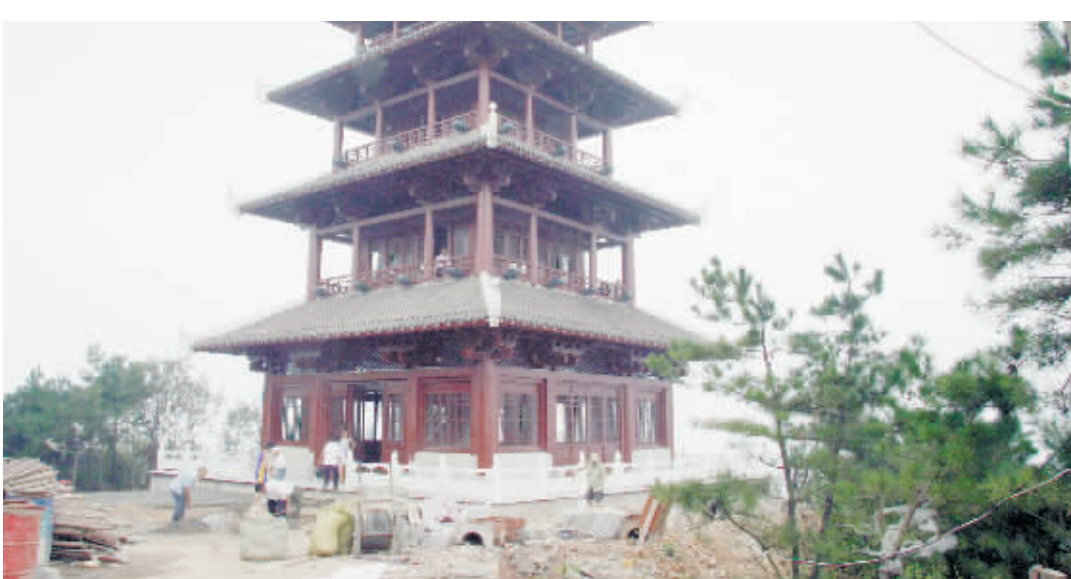
漯河八景中,建在安桥南岸临山麓上的平山塔施工难度可谓最大。因山高路陡,塔体建筑材料靠临时架设的简易索道一点点拉运上山,而铺设登山步道所用的2600多块大石条全靠人工抬上去。经过施工人员的艰辛工作,目前平山塔主体工程、亮化工程已基本完工。图为工人正在做铺地坪等扫尾工作。 本报记者 方慧玲 摄
