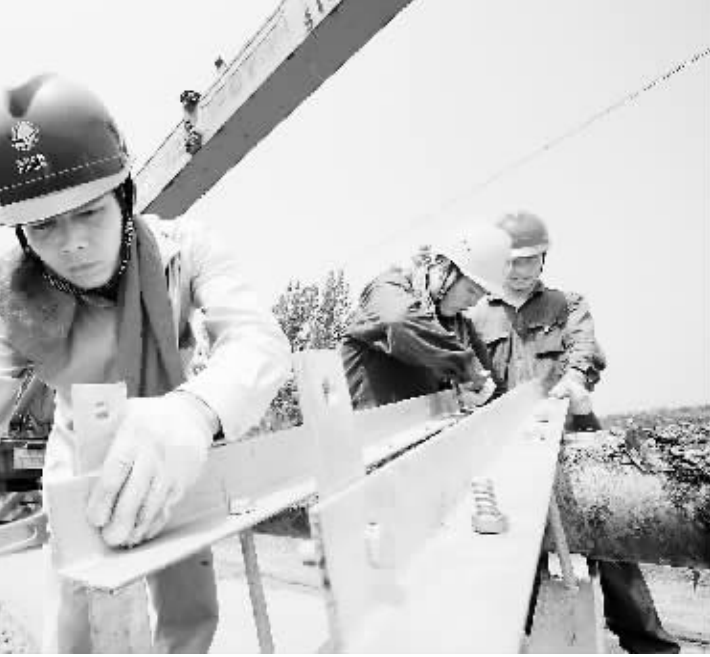
8月21日,在上天梯管理区,信阳供电公司工作人员顶着烈日组立电杆,为正在建设中的南湾二级水电站架设输电线路。 王强 李斌 摄
