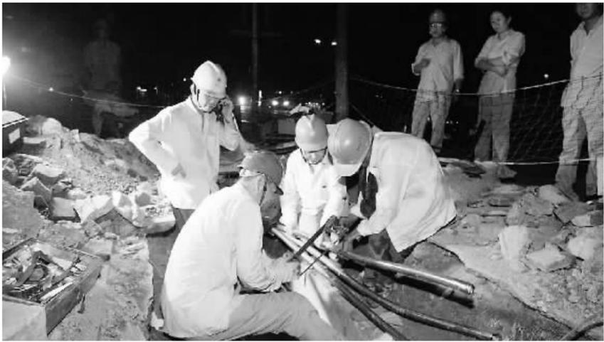
8月12日,市区大庆路一供电电缆过负荷被烧毁,信阳供电公司抢修人员连夜开展抢修,快速恢复供电。图为抢修时的情景。甘仁伟 摄
