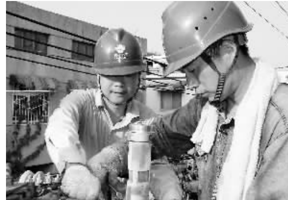
8月4日,随着气温的不断升高,信阳电网日供电量再创历史新高,信阳供电公司加大了配网抢修力度,以确保城区用电无虞。图为该公司人员抢修时的情景。杨宝明 摄
