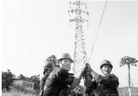
8月2日,信阳供电公司工作人员冒着酷暑,对110千伏信五、信侯线进行改造,确保高温大负荷下电网安全稳定运行。图为该公司人员施工时的情景。王强 摄
