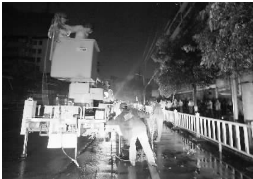
7月17日夜,雷雨造成市四一路供电线路故障,信阳供电公司工作人员快速行动,冒雨修复受损线路,恢复了供电。刘金生 王强 摄
