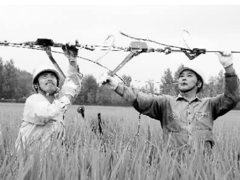
7月20日6时,罗山县电业局竹竿供电所黄湖村南台区变压器遭雷击烧毁,抢修人员经过3个小时的紧张抢修,10时恢复供电。图为抢修人员在稻田施工时的情景。陈则勇 吴培明 摄
