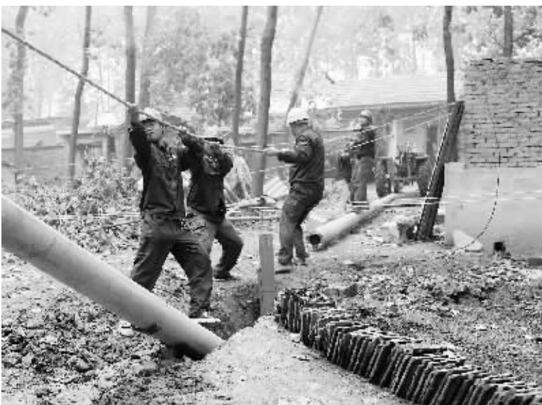
7月19日,龙卷风突袭淮滨县,刮断的大白杨树砸在供电线路上,造成多条线路出现故障。图为供电抢修人员冒雨抢修受损线路时的情景。陈建侠 摄
