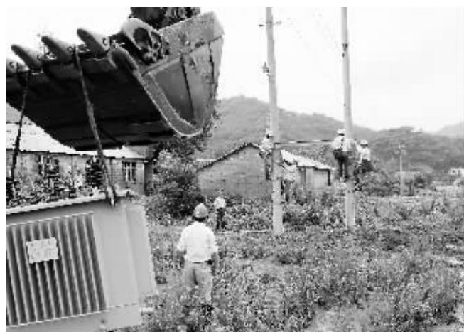
7月16日夜,鸡公山管理区李家寨镇龙泉寺村谢桥台区变压器被洪水冲走,供电抢修人员快速在安全区域重新架设一个配电台区。图为施工时的情景。王强 摄
