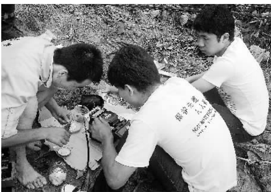
日前,平桥区普降暴雨,移动公司多处传输线路被冲断,多个乡镇通信瘫痪。对此,平桥移动分公司立即启动应急预案,分公司经理陶勇带领班子成员、网络运营维护人员、网络技术人员立即前往事故发生地进行抢修。截至目前,传输线路已全部恢复正常。图为技术人员正在抢修通信光缆时的情景。
