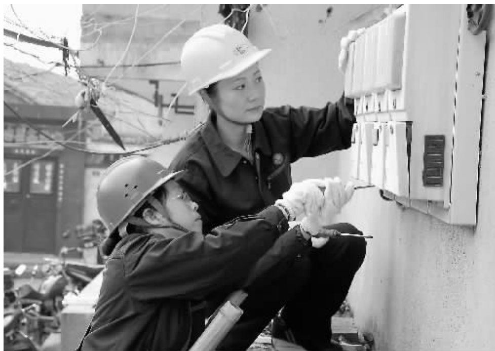
固始县电业局西关供电所维修班女工,巾帼不让须眉,担负着辖区繁重的低压维修任务,她们被广大客户亲切地称作“电火花”。图为7月13日,该所维修班女工在大别山南路排除低压故障。陶文胜 张杰 摄
