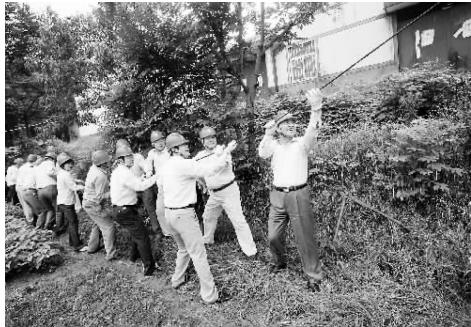
7月14日,信阳供电公司领导和机关中层干部在平桥区一处工地同施工人员一起拉扯导线。甘仁伟 摄
