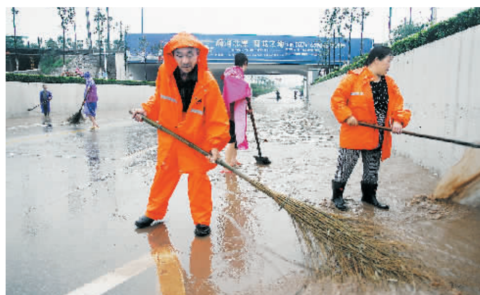
7月17日,羊山新区市政管理处共出动150多人,对羊山新七大道京广铁路涵洞1.5米深的积水进行排除。他们一边利用水泵抽水,一边组织环保工人清扫淤泥、垃圾,在最短时间内使该处交通恢复。 本报记者 秦旭 摄
