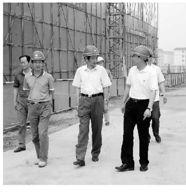
图为市住房和城乡建设局局长程震南(中)在施工现场检查指导安全生产工作。本报记者 肖胜 摄
