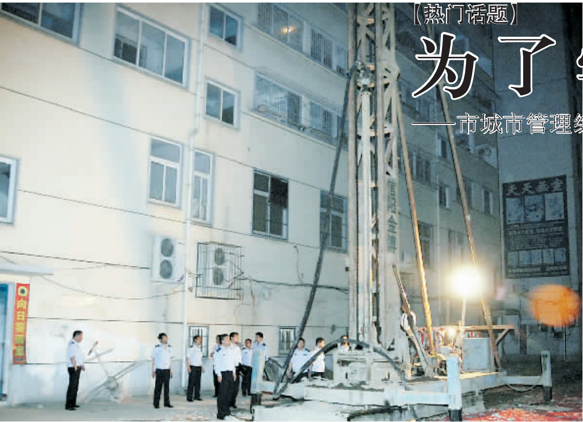
6月1日深夜,市城管综合执法局“夜巡中队”队员正在督促建筑工地整改。
