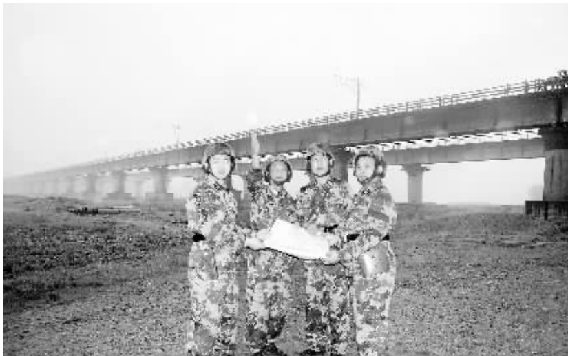
连日来,平桥区人武部为适应新形势、新任务的要求,对辖区内的重点防护目标进行实地勘察,研究防护措施,制定防护方案,为提高战时重要目标防护能力打下坚实基础。图为该区人武部负责人在长台关京广铁路大桥现场勘察时的场景。吴文柱 张威 摄
